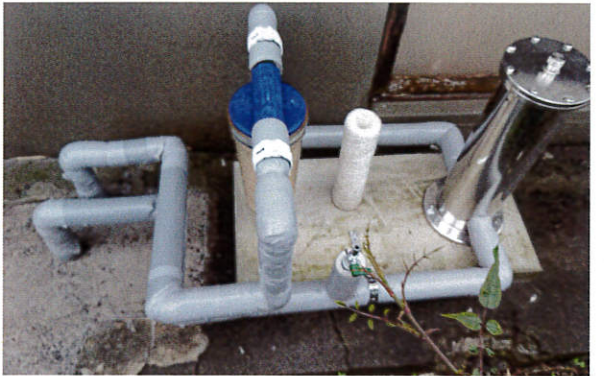
これまでの施工事例
